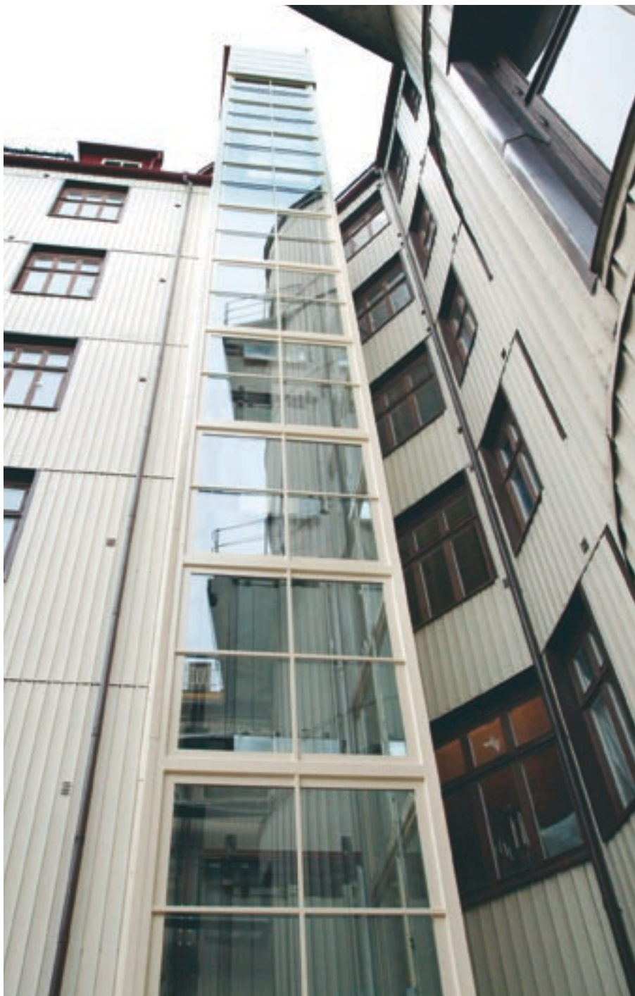
Två av tre sidor på hisschaktet är glasade för att lägenheterna intill ska få in ljus. Foto: Bror Augustsson, Kamerareportage.
