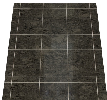
Stengolv med fyrhörnsläggning
