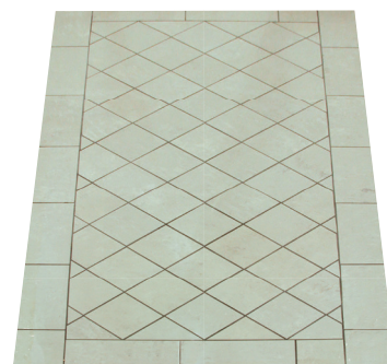
Stengolv med diagonal läggning och fris
