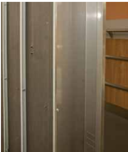
Utvändig ljudisolering. Sänker ljudnivån i hisskorgen.
