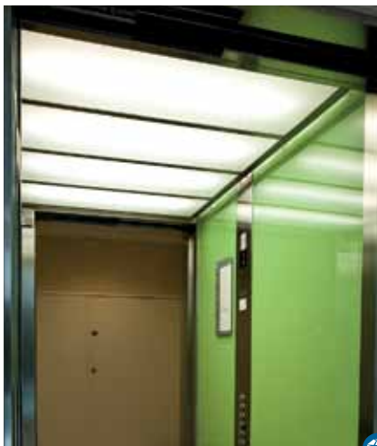
Vitt opalglas vilandes i rostfritt ramverk i nedpendlat undertak T5 ljusrör fast sken. Finns även med: - T5 ljusrör med sensor - LED-strip
