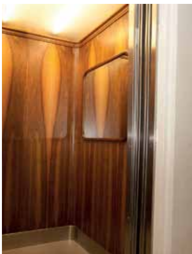
Nyttillverkad hisskorg i klassisk stil med valnötspanér och massiva tak- och spegellister.
