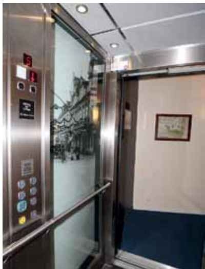
Fönster i hisskorg som visar motiv på schaktväggen.
