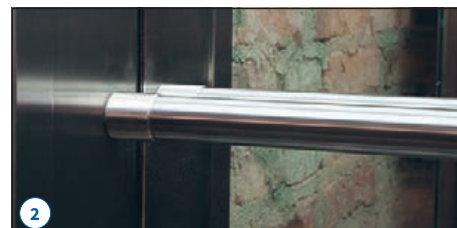
Rostfri anslutning mot vägg
