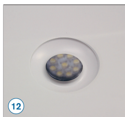
LED-spot, infälld, Ø=85 mm
