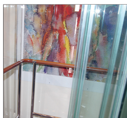
Hisskorgvägg i glas som visar motiv på schaktväggen
