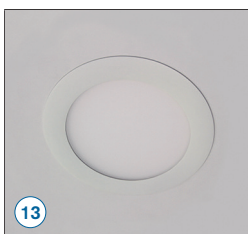
LED-belysning, infälld, Ø=200 mm
